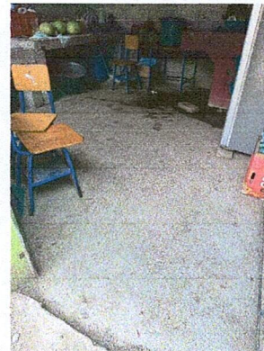
Foto 4: Mejoramiento de sustitución de azulejo de granito
